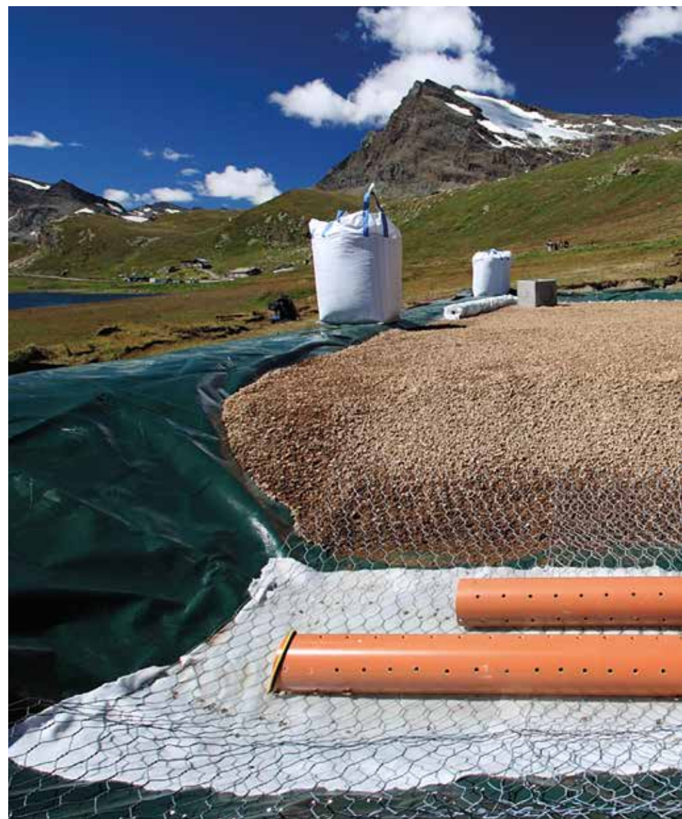
Figura 5. Una foto dell'area del Nicolet durante i lavori
