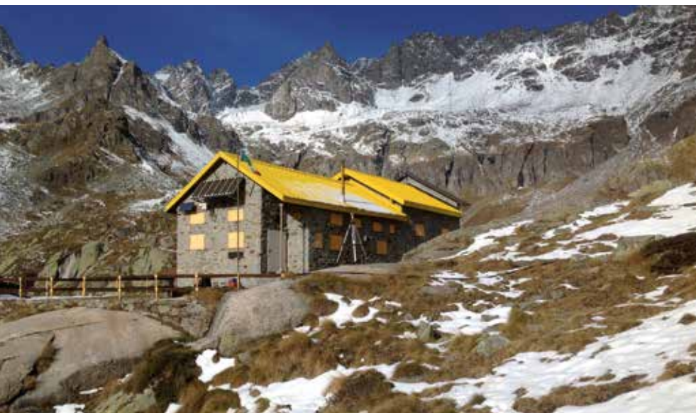
Figura 3. L'area di intervento. Nell'immagine di sinistra è visibile il Rifugio Pontese mentre nell'immagine di destra è rappresentata la vista del Lago di Teleccio dal rifugio.
